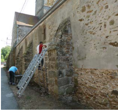
Ci-dessus – de gauche à droite : en 2012, la réfection de la voûte du bas-côté – le remplacement de quelques panneaux de bois sur le mur et la confection d'une nouvelle estrade sous l'autel – en 2013 : la réfection du mur extérieur nord
